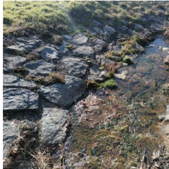
Negativbeispiel einer Nach-Sohlsicherung aus früherer Zeit mit hart verbauten Ufern und verbauter Sohle ohne Tiefenrinne
