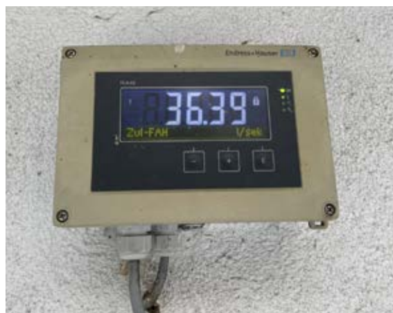
Anzeige der Restwasserabgabe: Dotation der FAH; Restwassertabelle; dynamische Restwasserabgabe*
