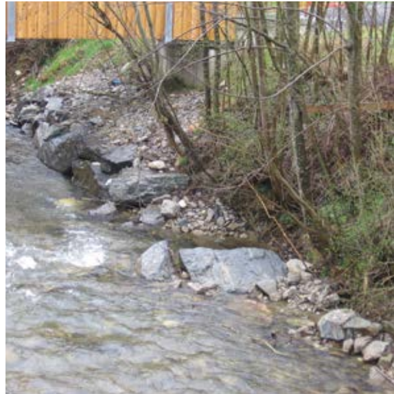
Berme aus Wasserbausteinen, etwas über Mittelwasserniveau mit gutem Anschluss ans Uferbegleitgehölz
