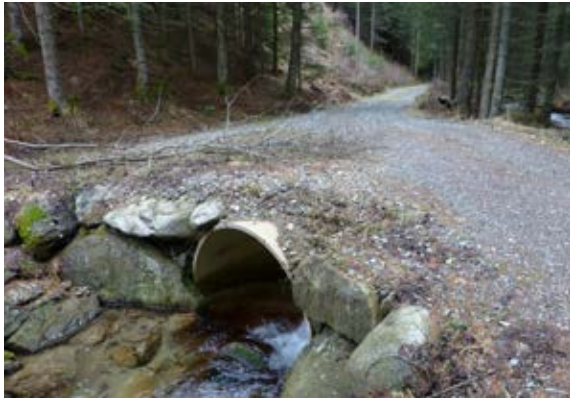
Verbautes Stück einer Druckrohrleitung aus dem Kraftwerksbau
