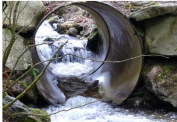
Glatte Sohle und Sohlabstürze vor und nach dem Rohr
