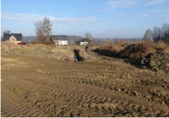
Verrohrung eines Gerinnes, für die im Nahebereich als Ausgleich ein kleines Biotop als Ersatzlebensraum errichtet wurde.
