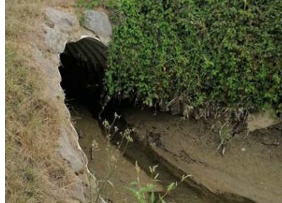
Sohloffener Wellrohrdurchlass
